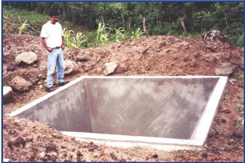
El reservorio está diseñado de forma que puede ser abastecido de agua a través de manguera, captar el agua directo de la lluvia o por escorrentía por medio de acequias.
